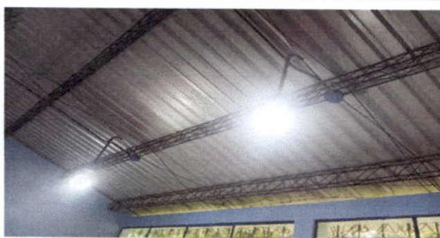
Foto 3: Mejoramiento de alumbrado electrico
