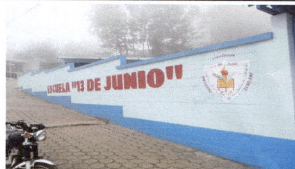
Foto 2: Pintura en muros interiores y exteriores
