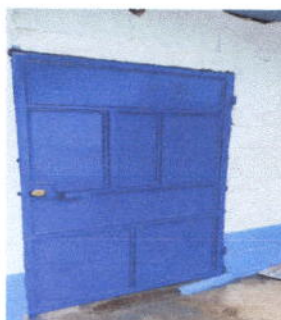
Foto1: Remozamiento de Puertas
