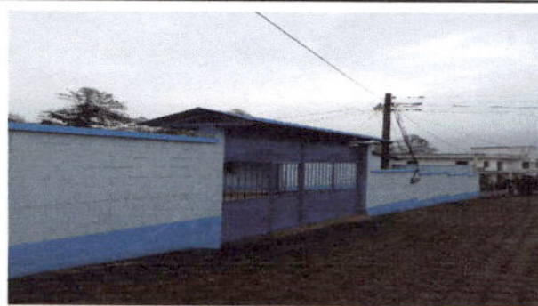
Foto 4: Remozamiento de portón de entrada principal
